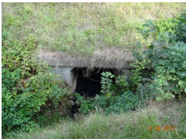
Detail propusti v tělese komunikace.
