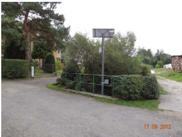
Automatický hlásný profil na mostku u garáží.
