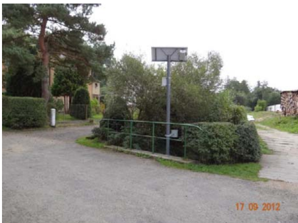
Automatický hlásný profil na mostku u garáží.
